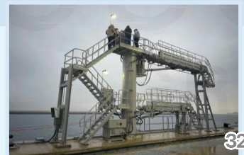
상부 설비 설치
